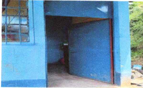
Foto 7: Mantenimiento en pintura de puertas en aulas
