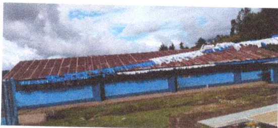
Foto 1: Sustitución de lamina por lamina troquelada aluzinc calibre 26 en modulo de aulas
