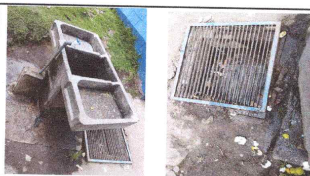
Foto 6: Sustitución de pilas de concreto de dos lavaderos
