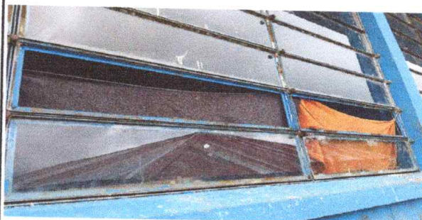
Foto 2: Sustitución de vidrios, por vidrios de aulas
